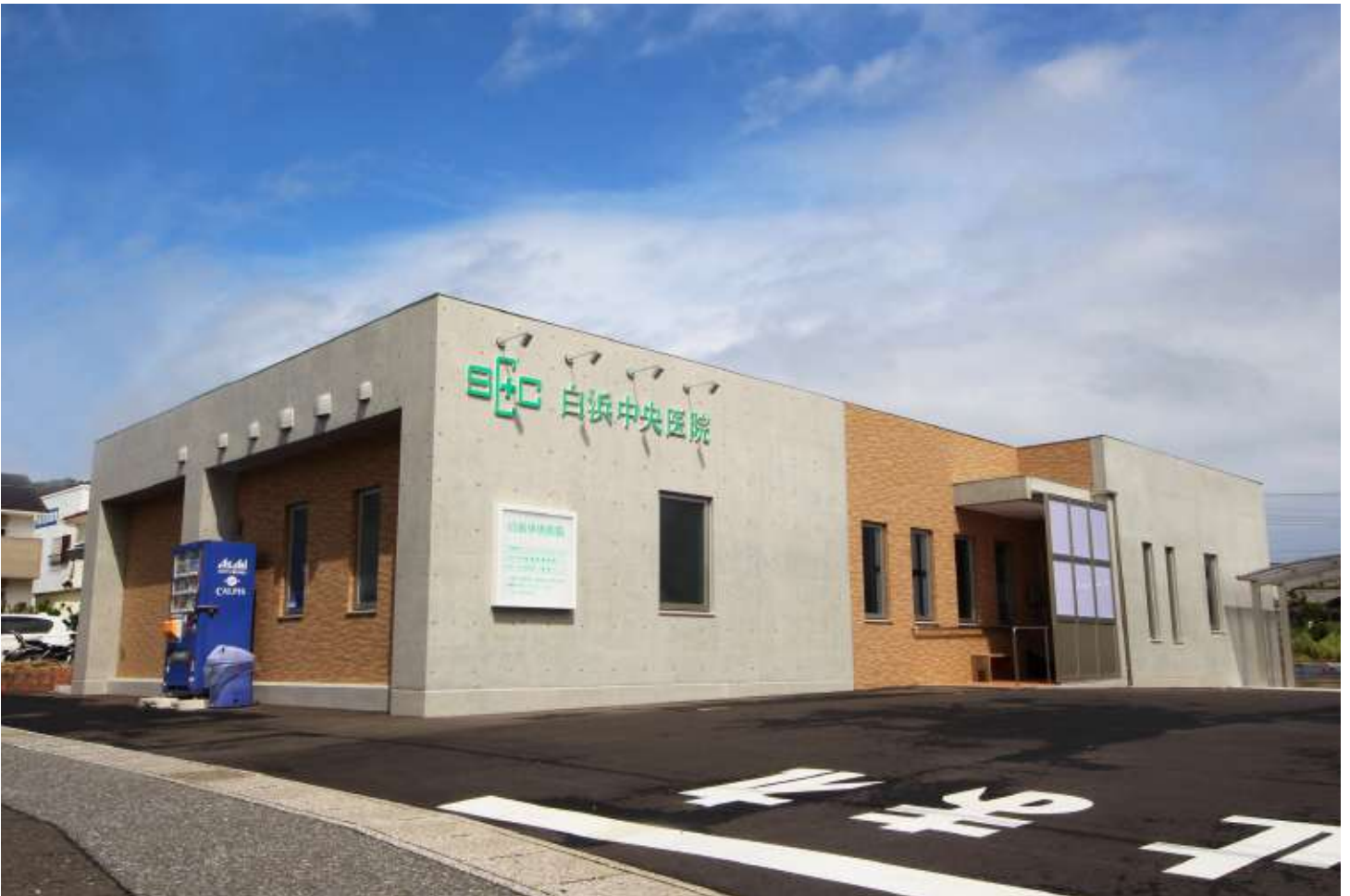
災害に強い建物にして欲しいと強いご意思、ご要望があった事から構造は鉄筋コンクリート造とした。外観はコンクリート打ちっ放しとタイルで仕上げ、丈夫に見えることから患者様にも安心感を与える。
